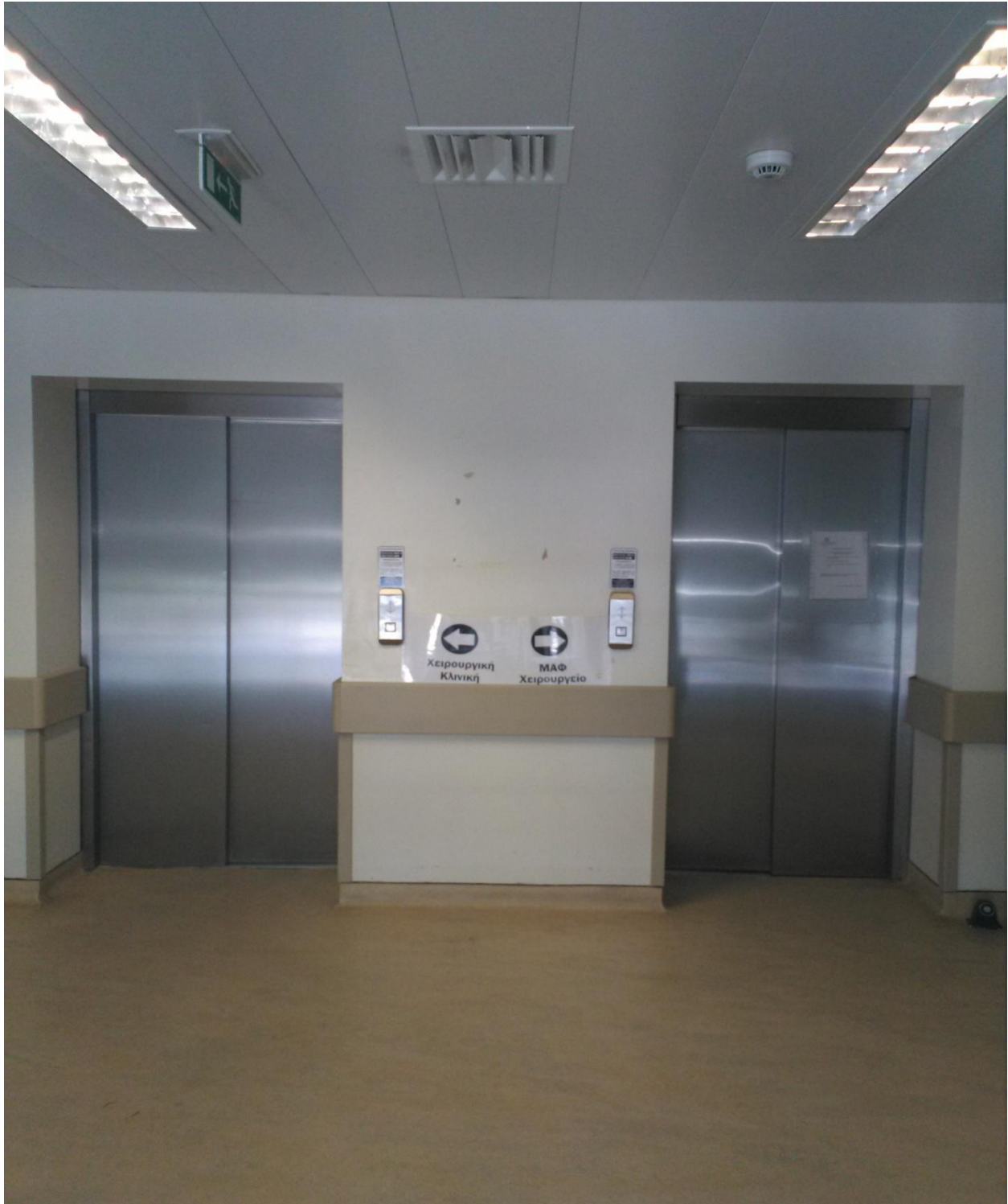
(Φωτο 11) Ασανσέρ μεταφοράς ακαθάρτων και ΕΑΥΜ στη νέα πτέρυγα.
