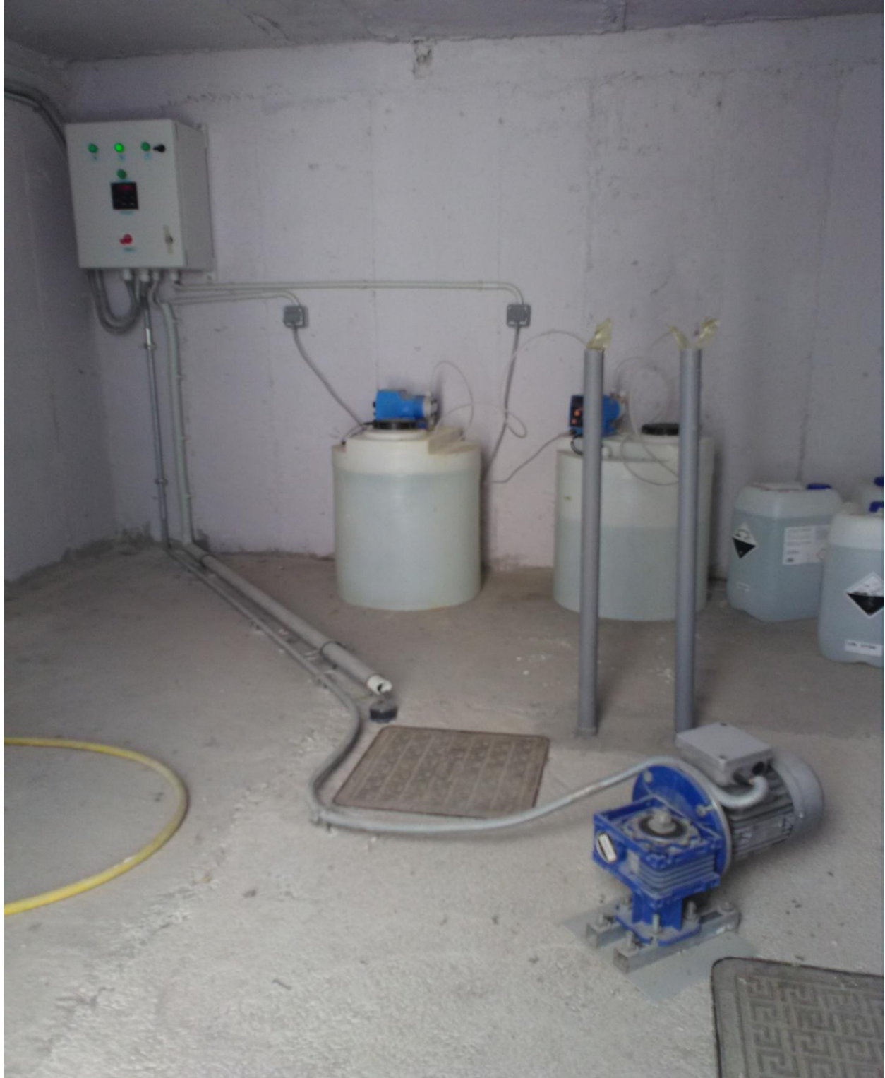
(Φωτο 3) Δεξαμενή αδρανοποίησης- χημικής εξουδετέρωσης υγρών αποβλήτων.
